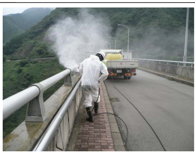
④堤頂パラペットの高圧洗浄
