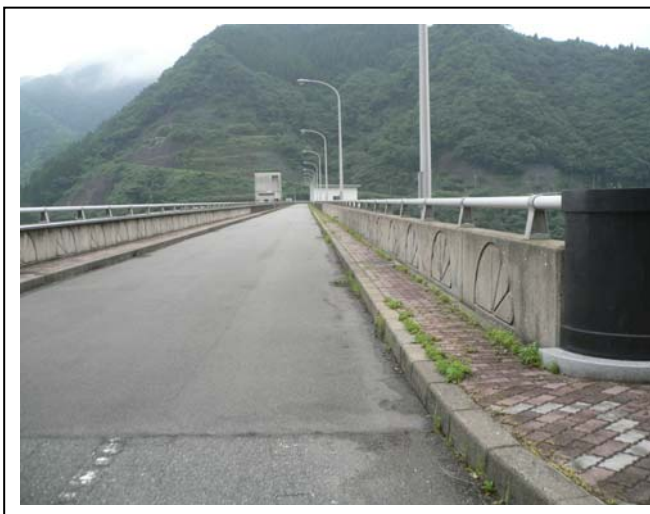
①清掃前のダム堤頂状況
