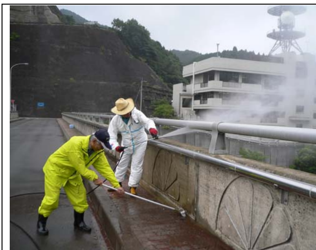
③堤頂高欄及び歩道ブロックの清掃
