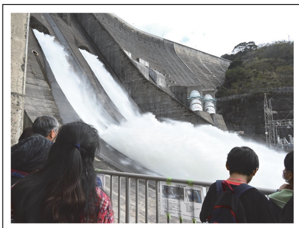
(11/24 堤体見学での点検放流)
