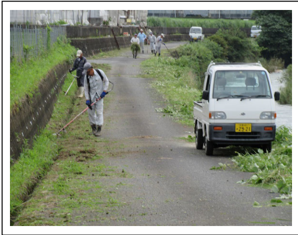
5 / 16 (ダム管理道路除草状況)
