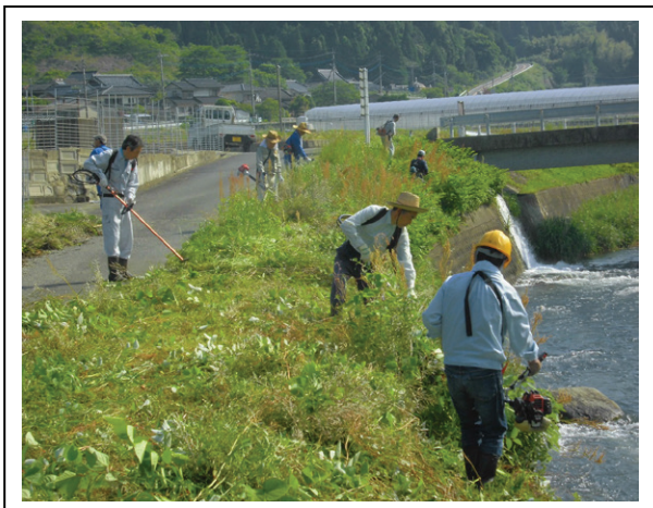
厳木ダム管理道・蛭ロード（除草作業）状況
