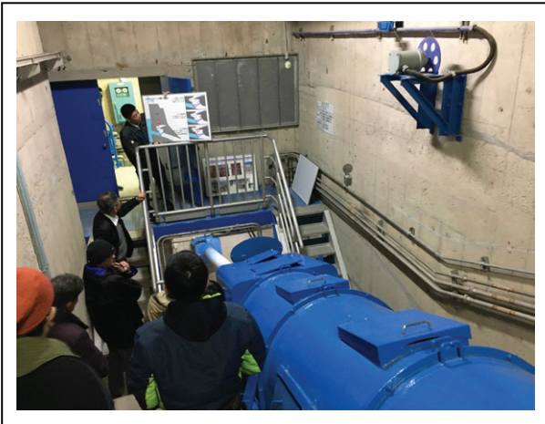
鶴田ダム内部の見学
