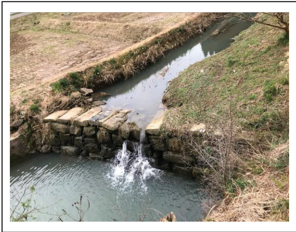
松浦川の石造井堰（松浦川流域に 75 件確認した）
