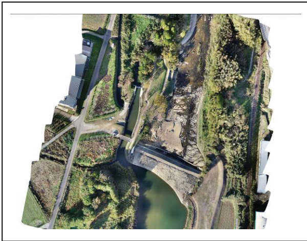
大黒井堰（ドローン撮影によるオルソ画像）
