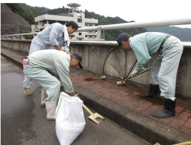
堤頂歩道部清掃
