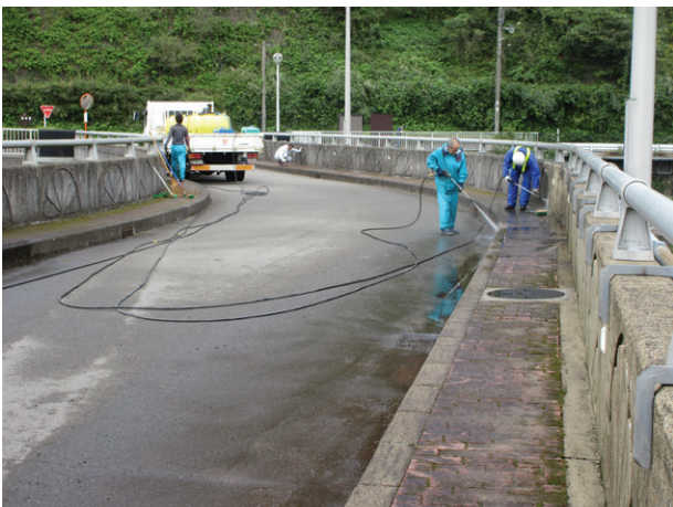
堤頂パラペットの高圧洗浄状況
