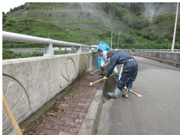
パラペットの高圧洗浄前と洗浄後の境目
