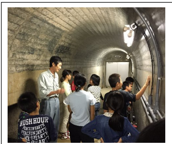
都川内ダム見学：監視機器
