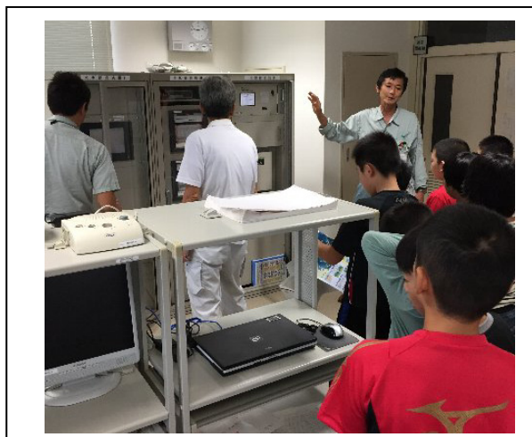
都川内ダム見学：監視機器
