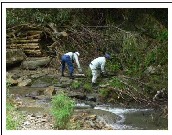
状況写真（河川内の倒木処理）
