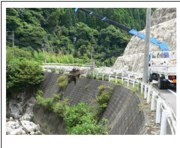
ユニック車によるゴミ引き揚げ作業
