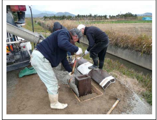
生コンクリート打設
