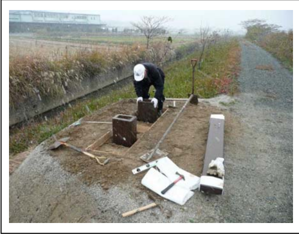
盛土部にベンチ基礎部の調整
