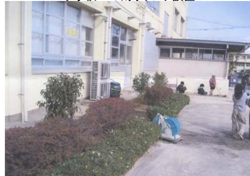
小学校への雨水タンク設置
