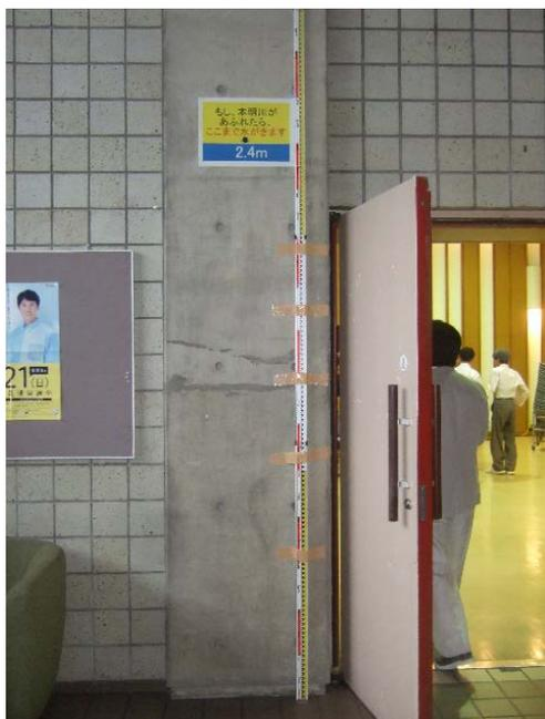
写真-8 本明川の洪水時の水位標の仮設置(諫早市市民センター)
