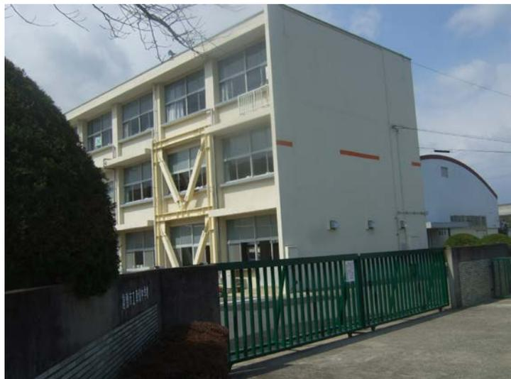
写真-11 倉敷市吉備真備中学校の校舎の壁面の浸水深の表示
