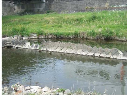
写真-5 河川内に残る旧河川の護岸
