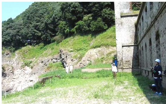
図 ドローンによるデータ取得の様子
