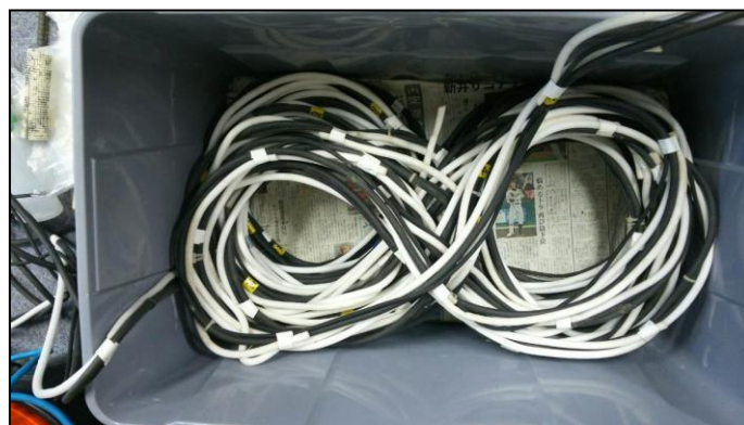
図13 交換したケーブル
