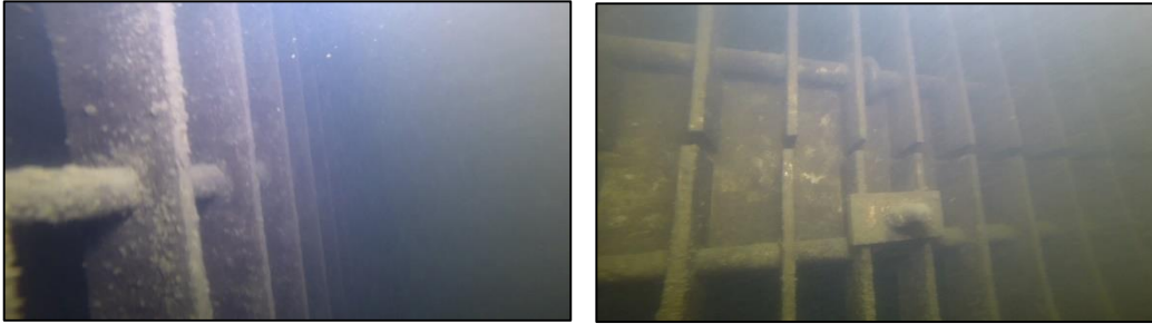
図8 北川ダム取水口スクリーン
