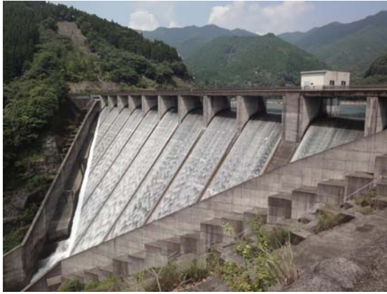
写真 3.1 広沢ダムの堤体
