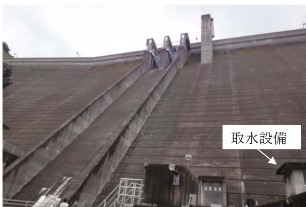
写真 3.5 瑞梅寺ダム堤体
