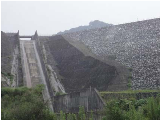
写真 3.3 木之川内ダム堤体
