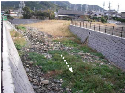
下流部瀨切れの様子 (河道整備前)
