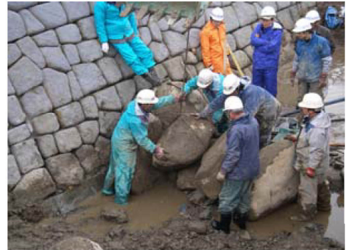
指導を受けながらの施工
