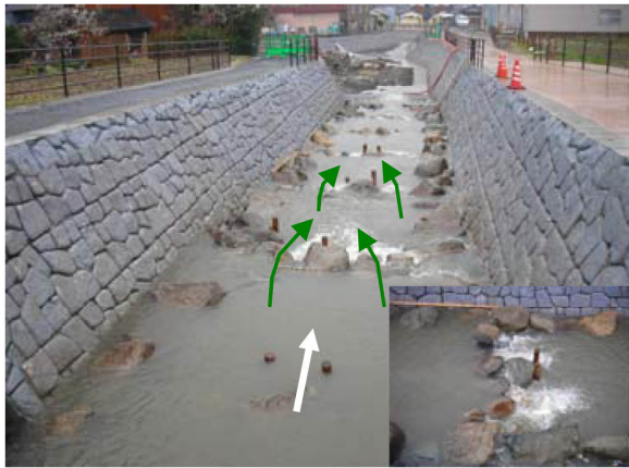
落差工完成直後の出水
